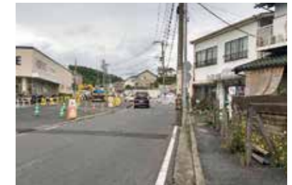
▲白根通り拡幅工事
