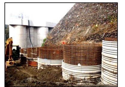
< 現状工事写真 10/17 撮影 >
