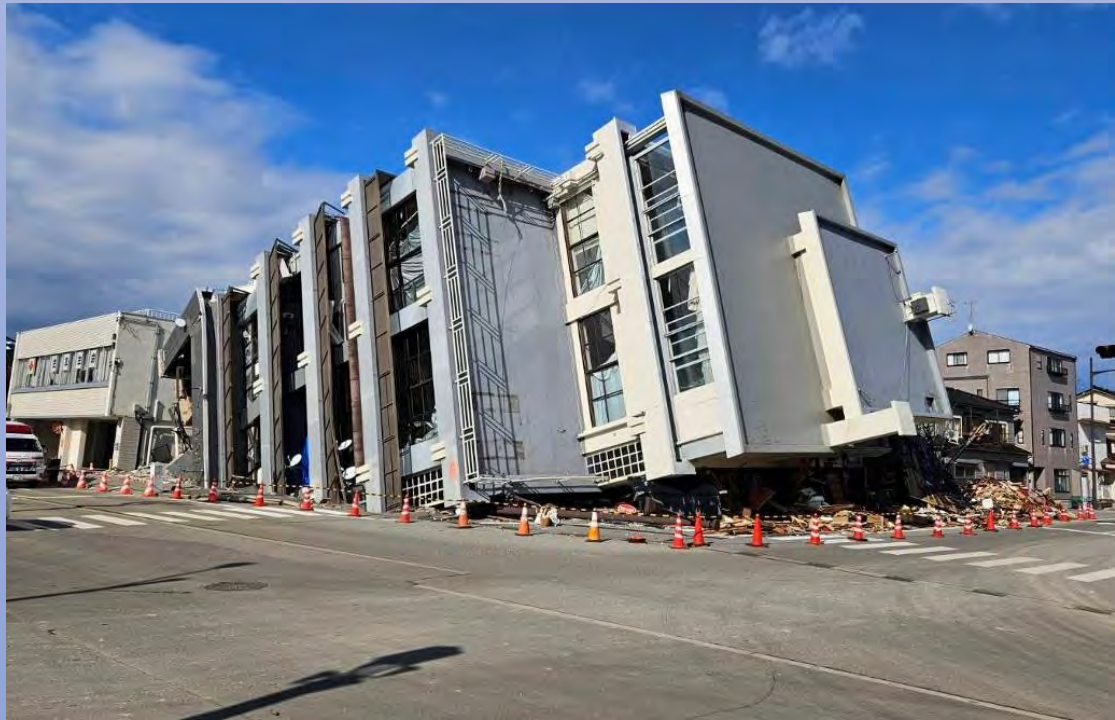
能登半島地震にて倒壊した建築物(輪島市)
