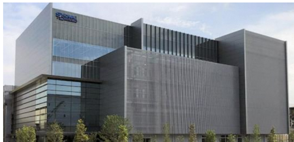
研究開発複合施設「共創の舞台」(昭和電工株式会社)の外観
