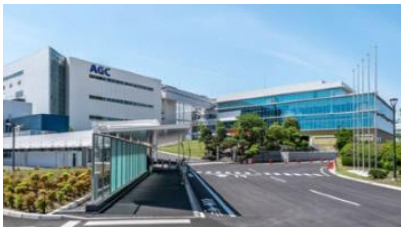
AGC横浜テクニカルセンターの外観
