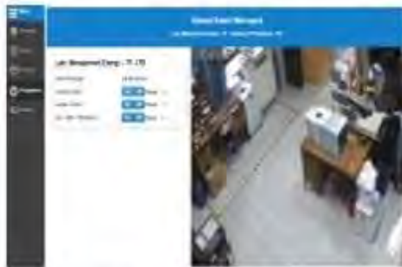
Monitoring dan Kontrol AC dan Lampu Lab. Manajemen Energi, Teknik Fisika ITB,
