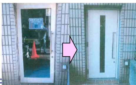
喫茶横外部扉交換工事
