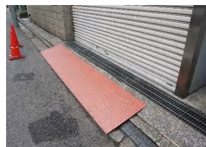
バックヤードに段差解消用 チェッカープレート新設
