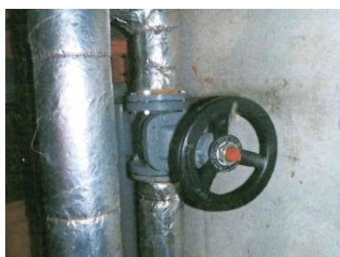
給水管バルブ工事 (3.5.6.7F)
