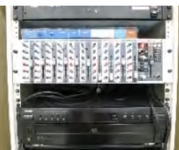
多目的ホールの拡声装置（ミキサー）を更新と同時に分かりやすい仕様書も新規に作成・設置。
