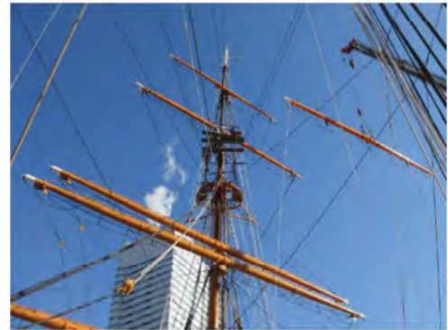
大型クレーンによる木製ヤードの取り付け
