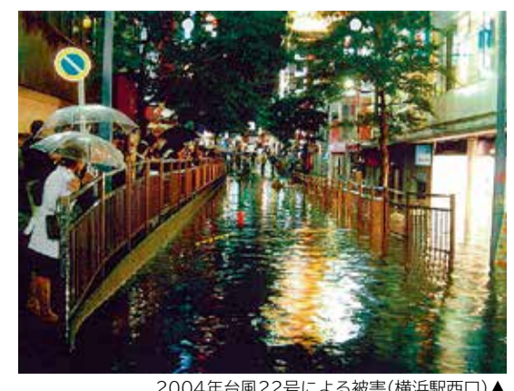
2004年台風22号による被害(横浜駅西口)▲
