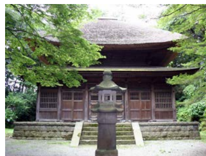
【旧東慶寺仏殿（重要文化財）】
