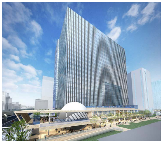
横濱ゲートタワー（全景）
