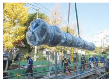
送配水管の更新工事
