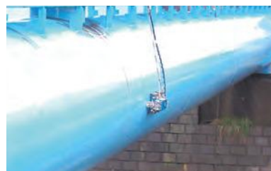
ロボットによる水管橋の点検
