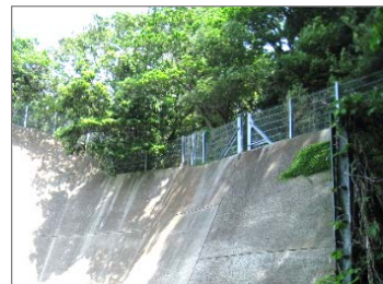
【斜面下側の擁壁例】
