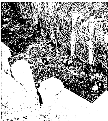
そだ工法による護岸
