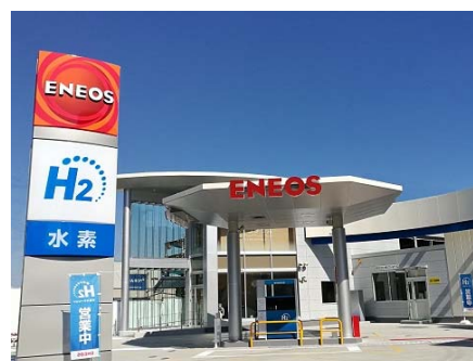
横浜綱島水素ステーション
