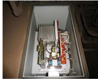
3000形車両蓄電池外観 画像
