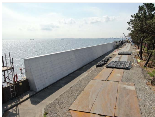
【既設パラペット嵩上げ工事】
