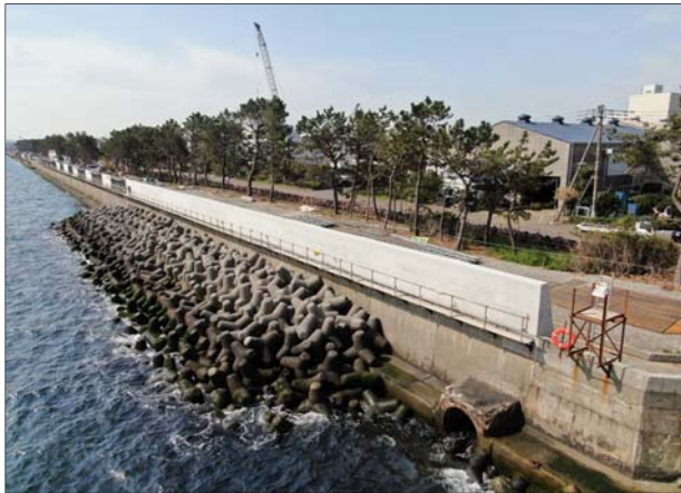
【金沢区福浦・幸浦地区護岸 復旧工事の様子】
