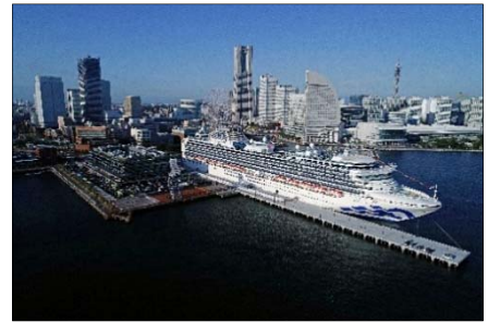
【新港ふ頭客船ターミナル】
