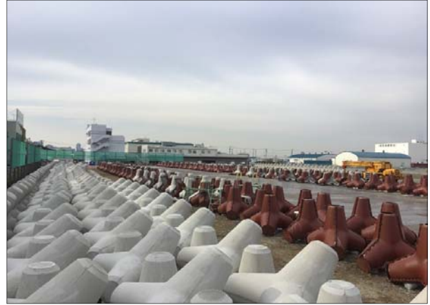
【消波ブロック製作工事】
