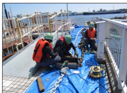
【ボンツーン係留チェーン交換】
