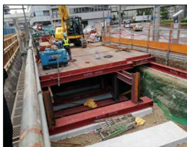
【護岸復旧工事】
