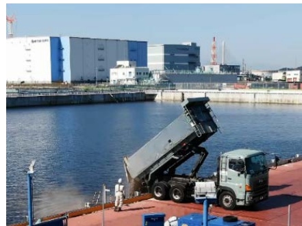
焼却灰を処分場へ投入する様子
