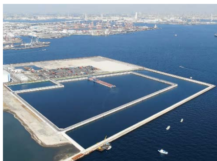
第5ブロック廃棄物最終処分場全景 (平成 29 年 10 月供用開始)
