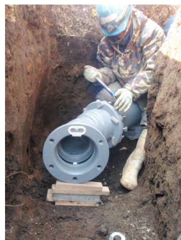
耐震管の布設状況
