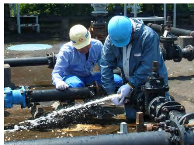
他事業体に対する 漏水調査・修繕研修
