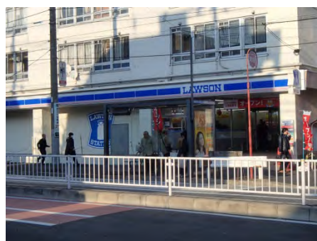
活用事例（旧南営業所の建物をコンビニエンスストアとして活用）
