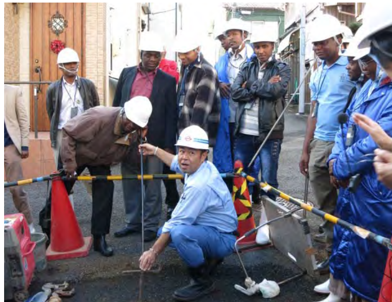
アフリカからの研修員受入れ（漏水修繕工事の様子）
