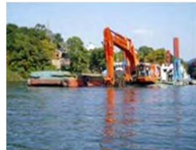
相模湖での土砂除去作業
