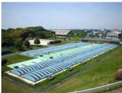
太陽光発電（小雀浄水場）
