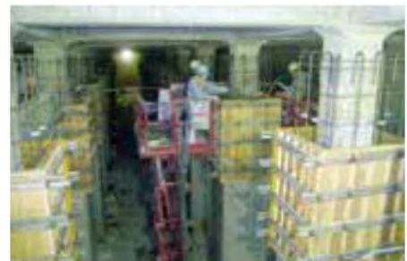
配水池の耐震化工事
