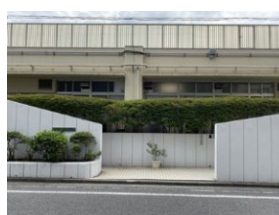
⑭東側道路より通用門を見る
