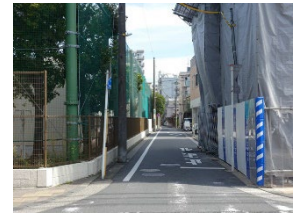
②グラウンド南側道路を見る
