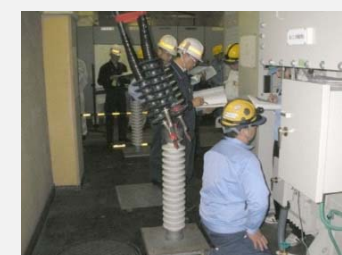
変電所更新工事
