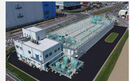
南本牧排水処理施設（平成29年10月供用開始）
