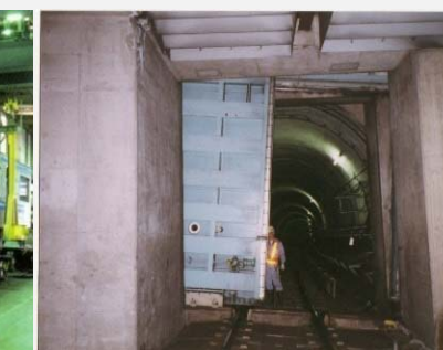
トンネル内設備の点検
