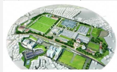
西谷浄水場（全体図）
