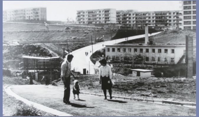
造成中の汐見台団地(昭和40年前後)
