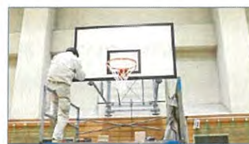
バスケットボールゴールの点検
