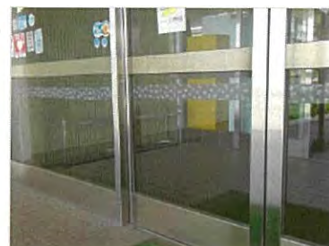
ガラス扉に張った衝突防止シール
