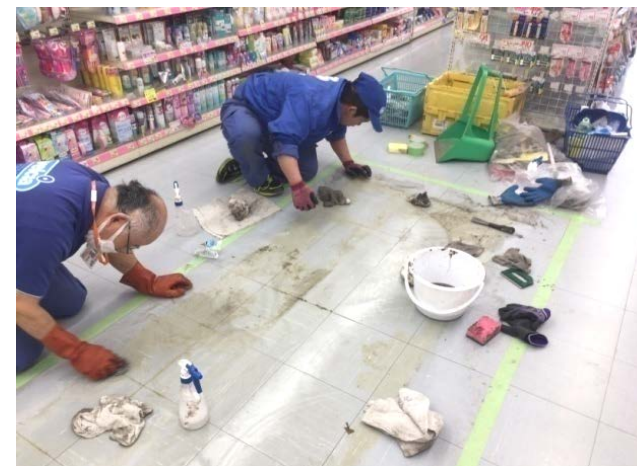
店内什器撤去・床清掃
