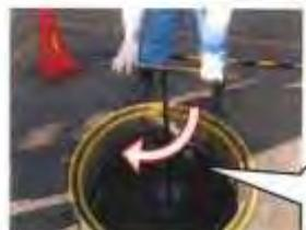
消火栓のキャップを外し、矢印の部分にバルブキーを立てます。
