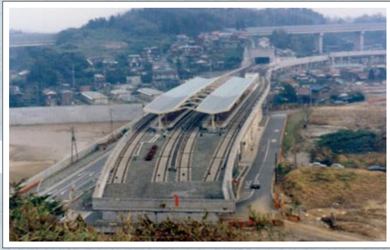
開業時の市営地下鉄上永谷駅 (1977年 横浜市港南図書館所蔵)
