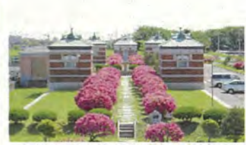
西谷浄水場濾過池整水室上屋3号棟 他
