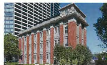
旧横浜生糸検査所附属倉庫事務所
