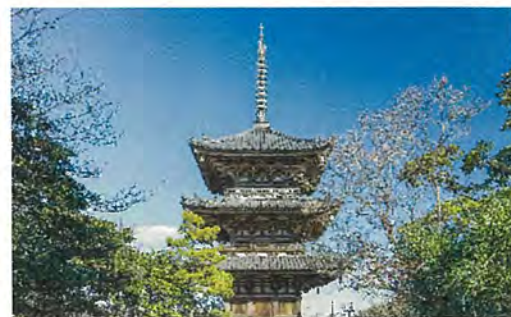
【図1-35】 旧燈明寺三重塔
