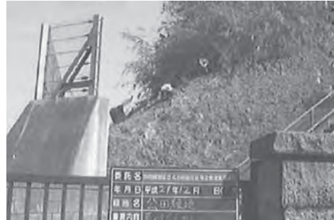
（施工後）民家への危険がなくなりました。
