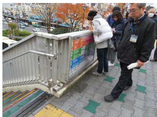
歩道橋の点検
