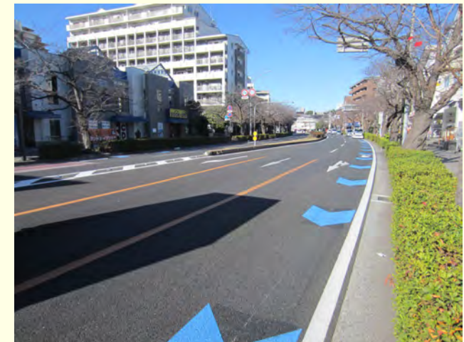
R4整備箇所
