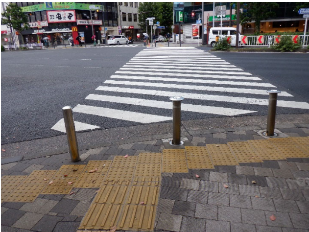
整備前<令和4年9月>
