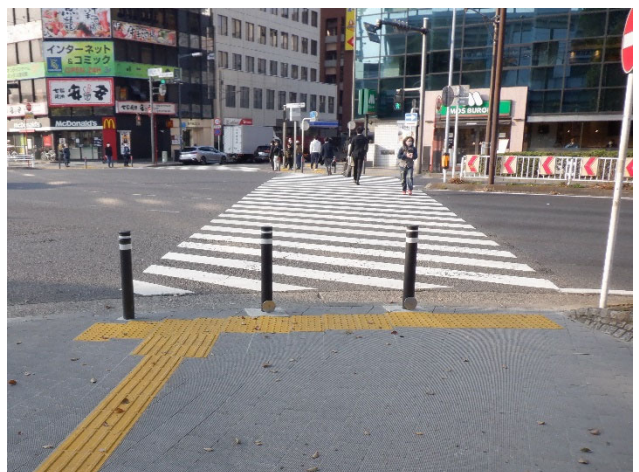
整備後<令和5年3月>
