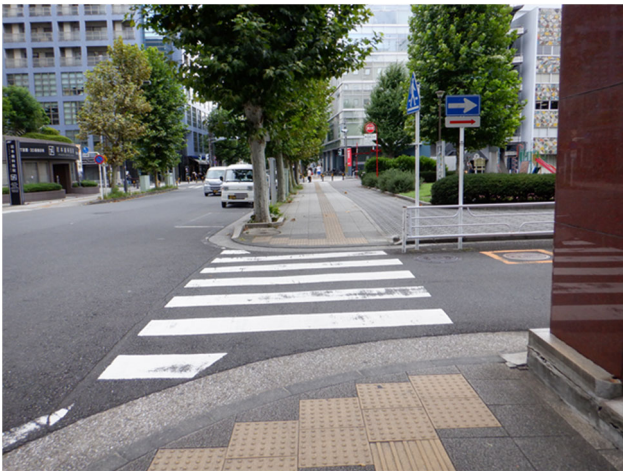
整備前<令和4年9月>
