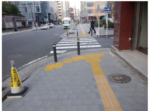
整備後<令和5年3月>
