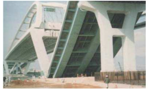
■阪神高速道路の落橋状況 (西宮市甲子園西)
