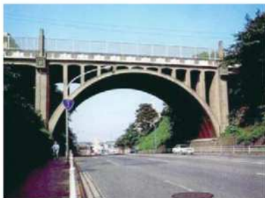
土木遺産として遺す橋の一例「響橋」
