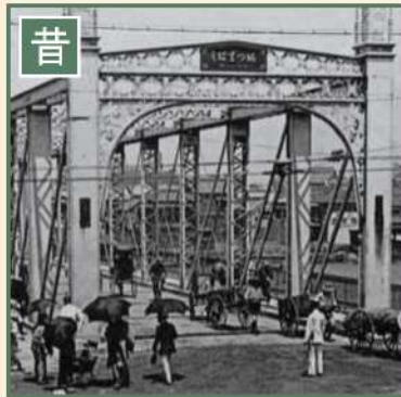
■明治20年に架けられた吾妻橋
