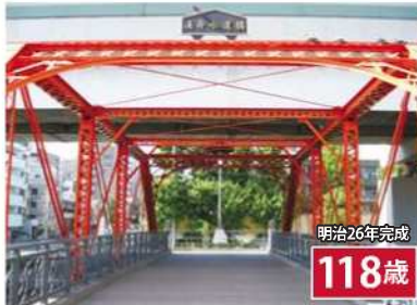
■浦舟水道橋(うらふねすいどうばし) 【旧鉄橋】
