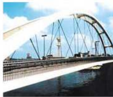
鶴見川橋(横浜市)
