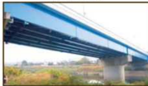
新川向橋全景
