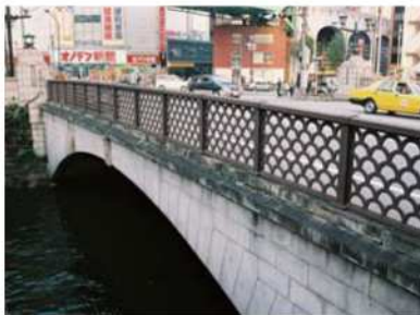
著名橋の一例「昌平橋」
