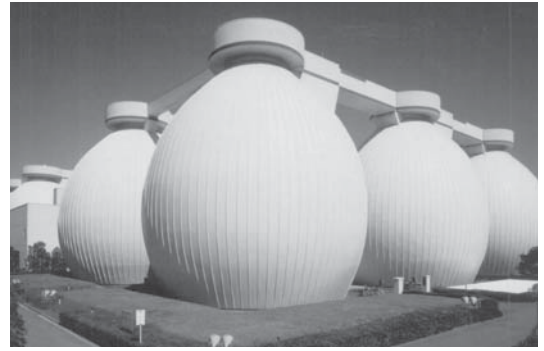
北部汚泥資源化センター消化タンク
