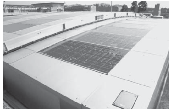
西谷浄水場覆蓋
