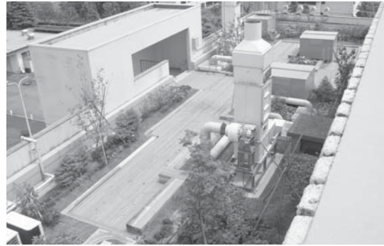
西谷浄水場屋上
