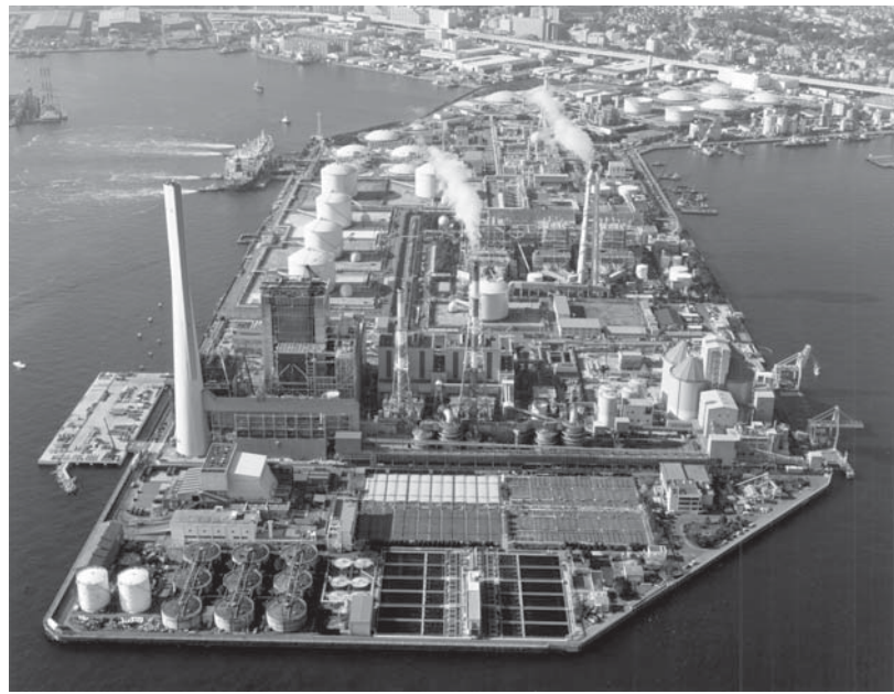
南部水再生センター (磯子区)
