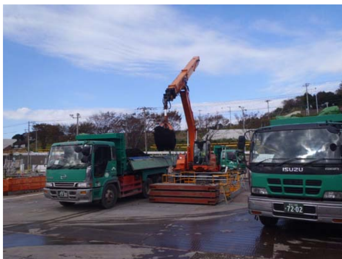
写真 3.3.3-2 環境保全のための措置の実施状況（横浜市指定運搬先への搬入）
