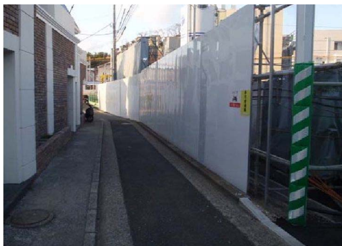
写真 4-1 環境保全のための措置の実施状況（仮囲いの設置）
