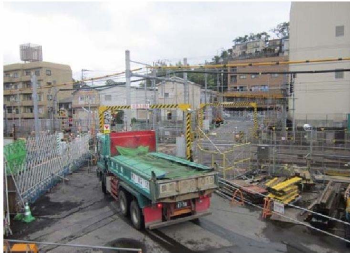
写真 4-4 環境保全のための措置の実施状況（工事用車両の荷台への防塵シートの敷設）
