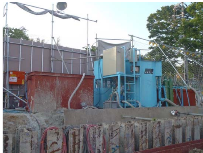
写真 4-8 環境保全のための措置の実施状況（工事排水の管理（濁水処理プラント））
