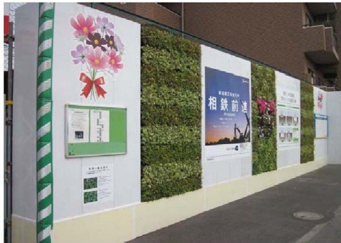
写真 4-10 環境保全のための措置の実施状況（工事計画の周知（工事案内掲示板））
