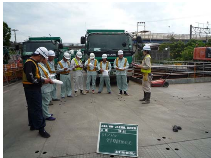
写真 4-9 環境保全のための措置の実施状況（安全教育）
