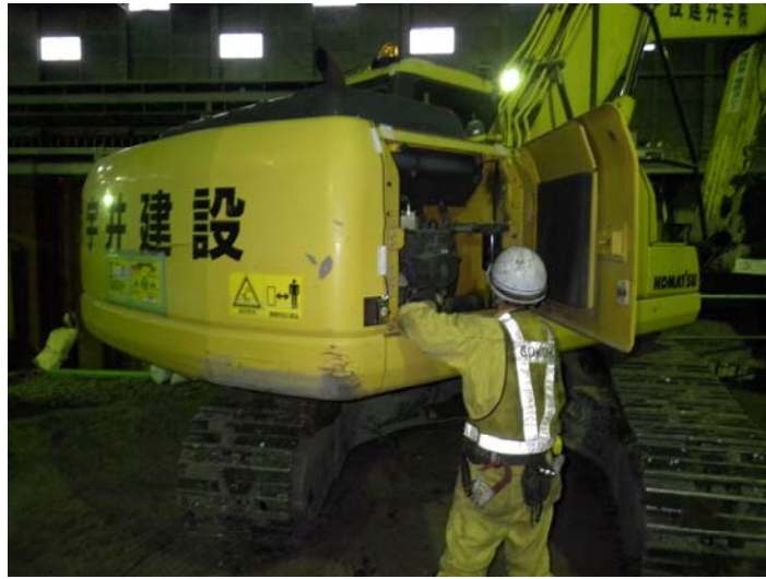
写真 4-7 環境保全のための措置の実施状況（定期点検・整備②）
