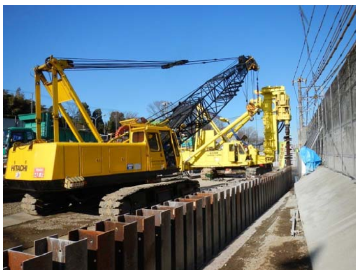
写真 3.3.2-1 環境保全のための措置の実施状況（止水性の高い連続壁の設置）
