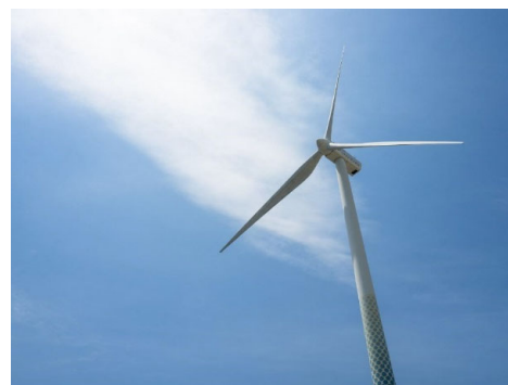
横浜市風力発電所 ハマウィング
