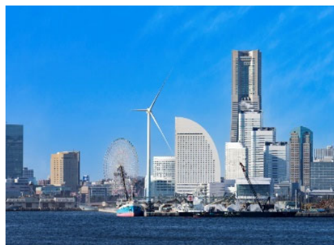
横浜市風力発電所 (ハマウイング)
