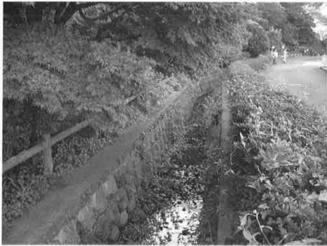
M3 宮川 清水橋上流
