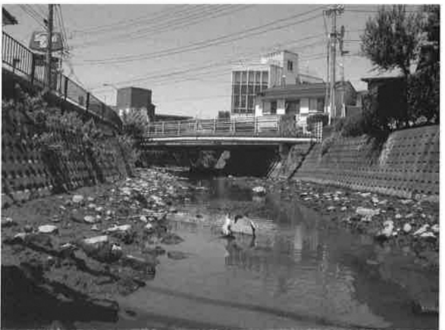
J2 侍従川 六浦二号橋
