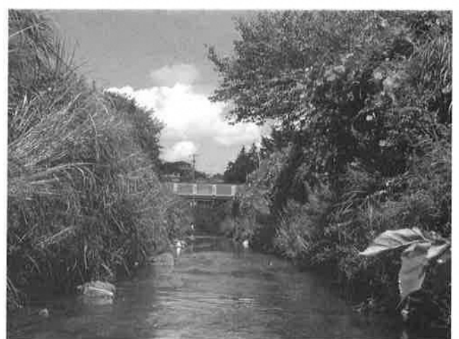
0 3 大岡川 曲田橋
