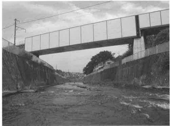
T 7 鶴見川・恩田川 堀の内橋
