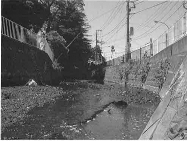
M2 宮川 宮川橋
