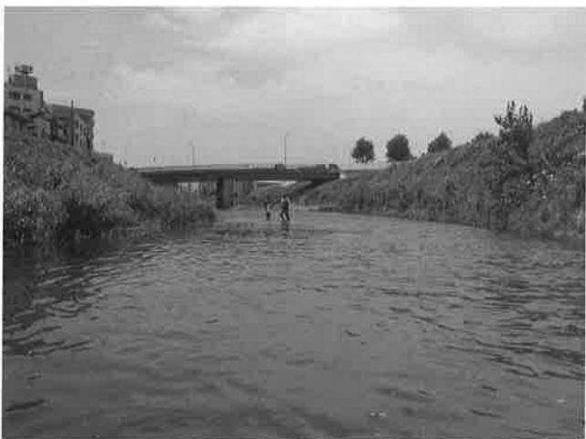
T 8 鶴見川・恩田川 都橋
