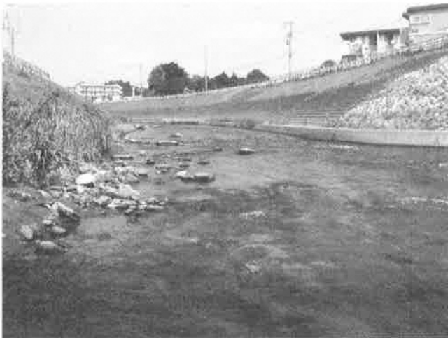
T 1 鶴見川 水車橋
