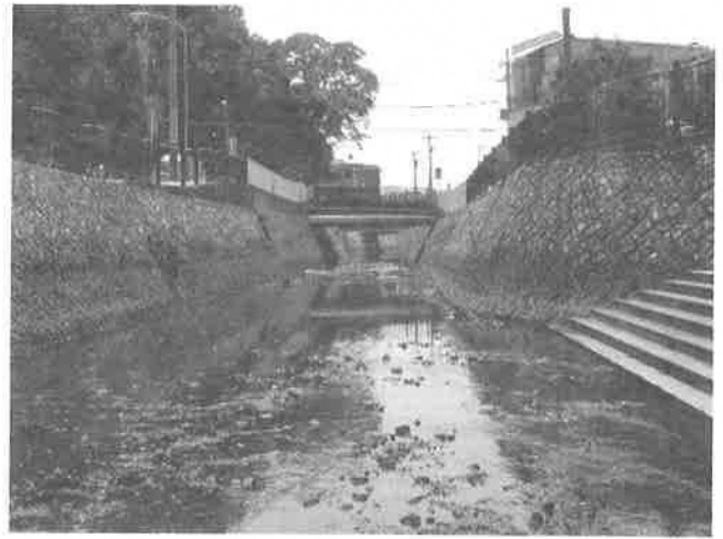
M2 宮川 桜橋(上流側に前回までの調査地点の宮川橋が見える)
