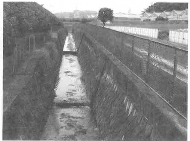
T 4-2 鶴見川・大熊川 掘込橋
