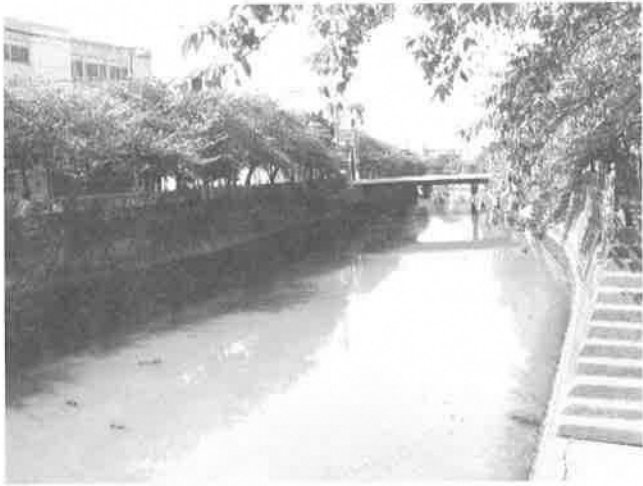
04 大岡川 井戸ヶ谷橋
