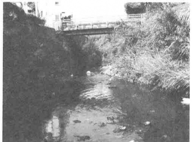
0 3 大岡川 曲田橋
