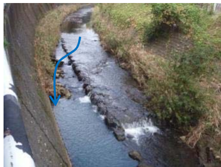
写真1 高山人道橋上流付近の岩盤掘削
