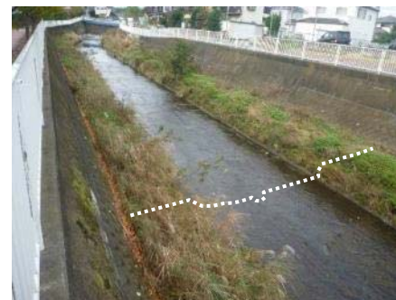
写真3 用地橋上流付近の岩盤掘削
