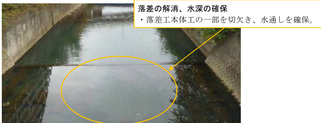
図 5-7 上流護床ブロック対策イメージ図
