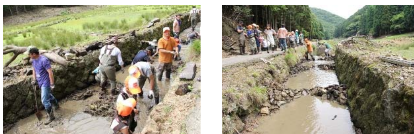
兵庫県豊岡市「田結湿地」における上向き水制の設置の事例
