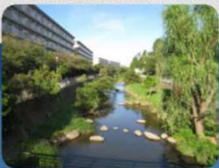
多様な流れの創造(巨石の配置) いたち川 (横浜市栄区)
