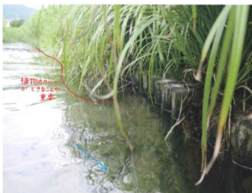
図 5-15 水際植生および大石の配置(浅場の創出)イメージ
