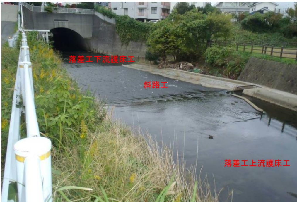
写真 5-3 斜路工部全景
