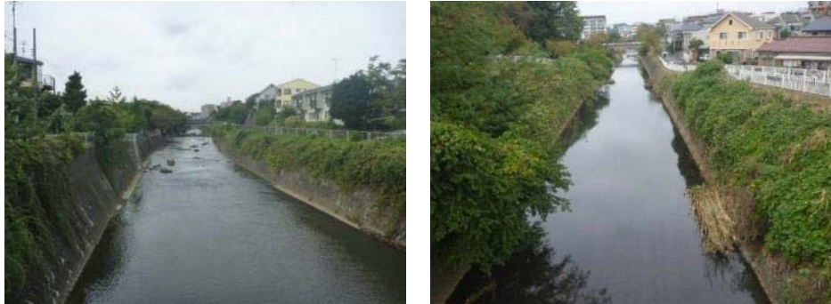
写真 5-6 嶋越橋上流 (左)・公園橋上流 (右) の河道
