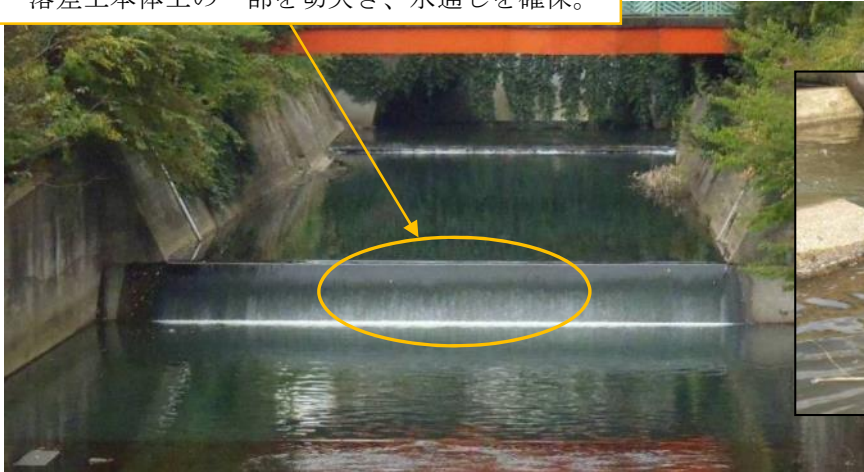
・ 落差工の縦壁の切欠き事例
