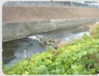
⑥公園橋下流落差工
