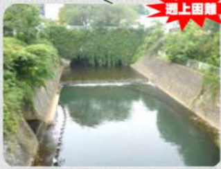
④鶴峰橋上流落差工
