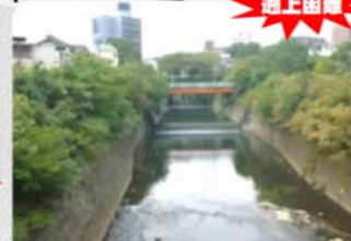
③鶴峰橋下流落差工
