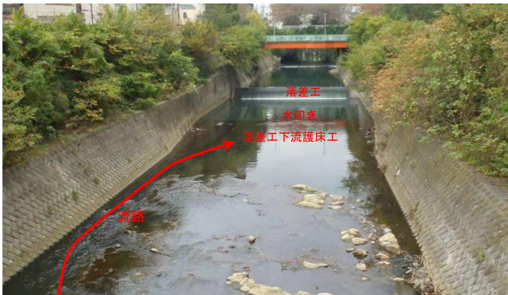
写真 5-1 落差工部全景
