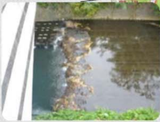
⑦公園橋上流落差工
