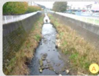
用地橋付近の河道 平瀬と早瀬が形成されているが、水際が直線的で、出水時の待避場所がない。
