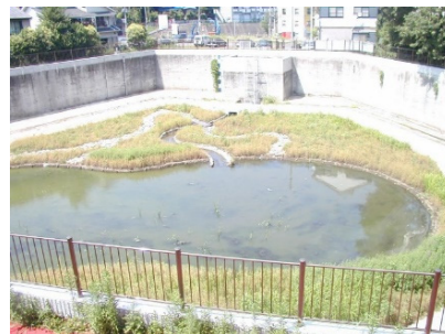
ビオトープ (三保第一雨水調整池)
