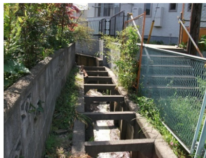
水路 (緑区 柵きょ形式の水路)
