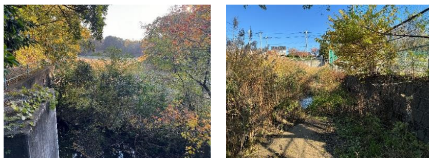
図 2-1 貯留機能が低下している施設
