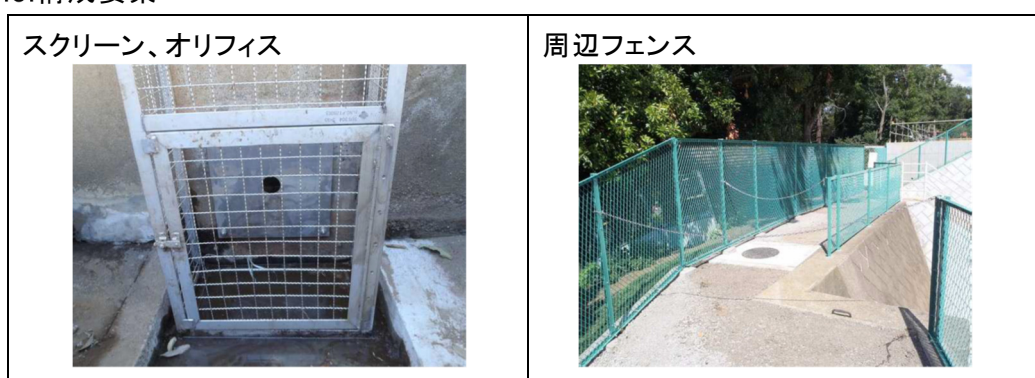
図 1-3 雨水調整池の付帯施設
