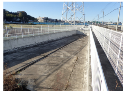
雨水流出抑制施設 (緑区 北八朔地区雨水調整池)
