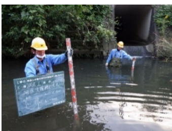
河道内の洗堀
