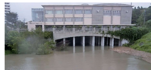
▲上部を地域ケアプラザとして利用(野庭団地第一雨水調整池)
