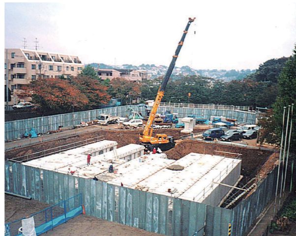
▲校庭での施設整備(北方小学校)
