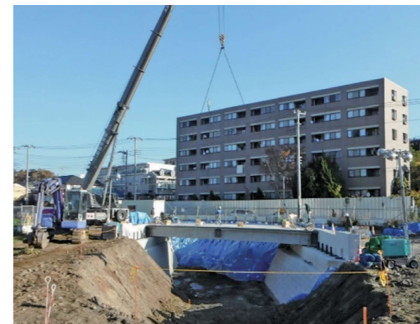
▲橋げたの架設状況（奈良川）
