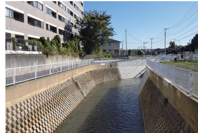
▲ブロック積護岸（奈良川）
