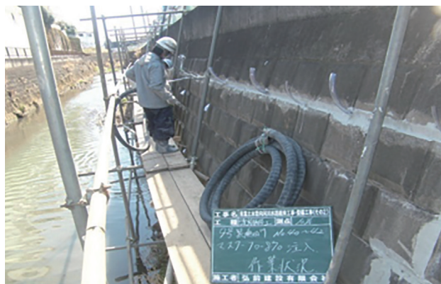
▲ 保全計画に基づく老朽化対策（黒須田川）
