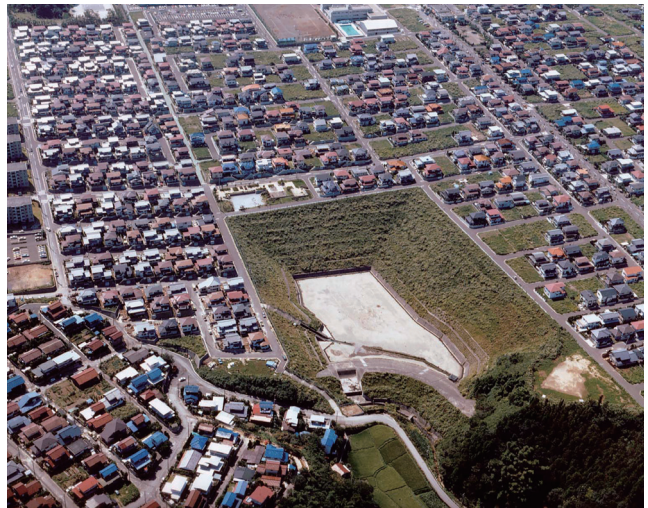
▲開発にあわせて設置された雨水調整池(栄区 桂台2号雨水調整池)
