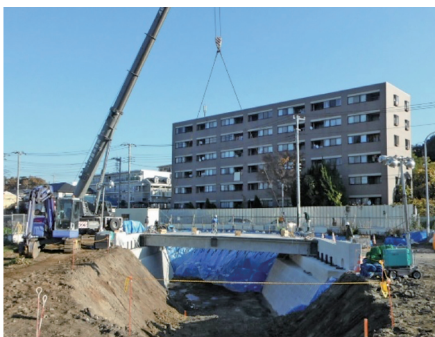
▲橋げたの架設状況（奈良川）
