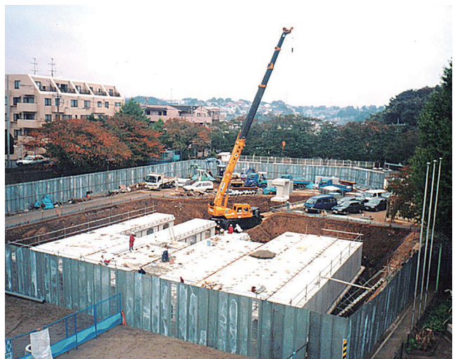
▲校庭での施設整備(北方小学校)
