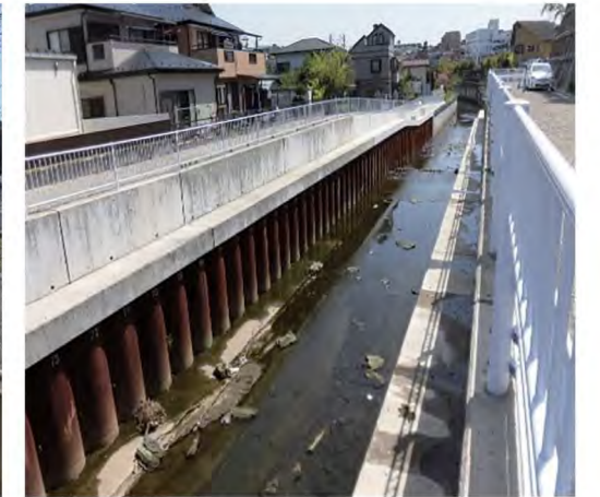
▲直壁護岸（今井川）
