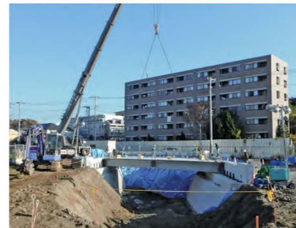
▲橋げたの架設状況（奈良川）
