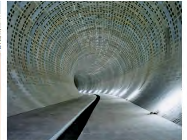
▲今井川地下調節池の内部
