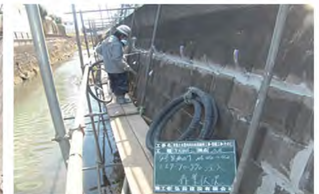
▲保全計画に基づく老朽化対策(黒須田川)
