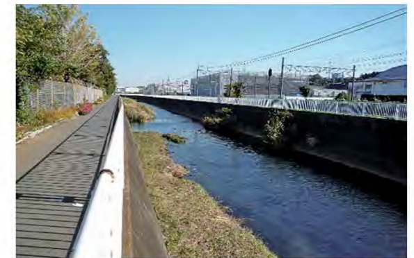
▲鉄道に隣接する特殊堤(平戸永谷川)
