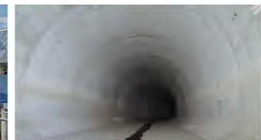
▲帷子川分水路のトンネル内部
