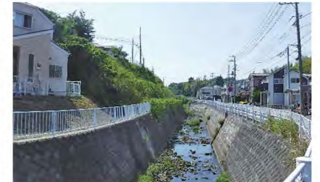
▲住宅地を流れる中堀川
