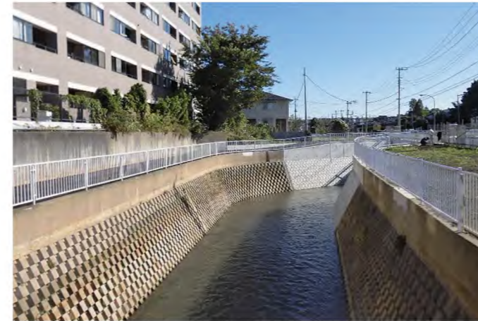
▲ブロック積護岸（奈良川）
