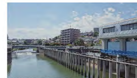
▲帷子川分水路入口
