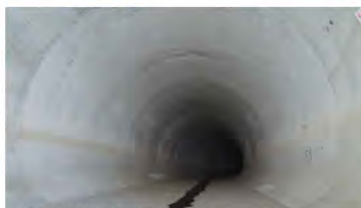
▲帷子川分水路のトンネル内部
