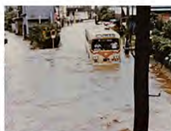
昭和51年9月洪水の浸水状況 (舞岡川:戸塚区舞岡町)
