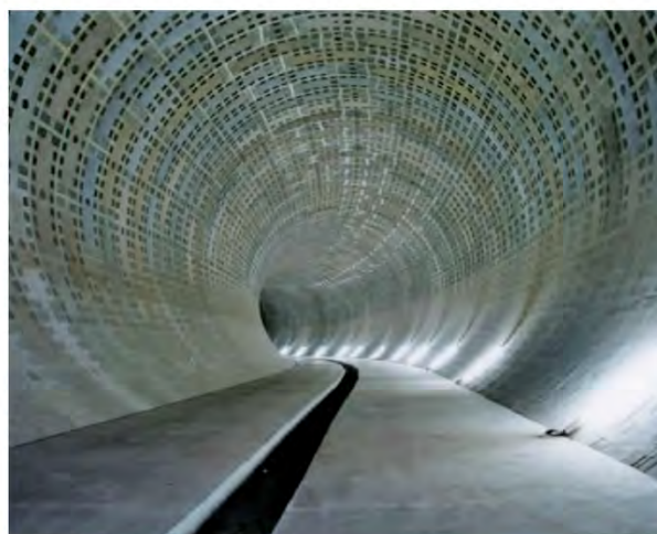
▲今井川地下調節池の内部
