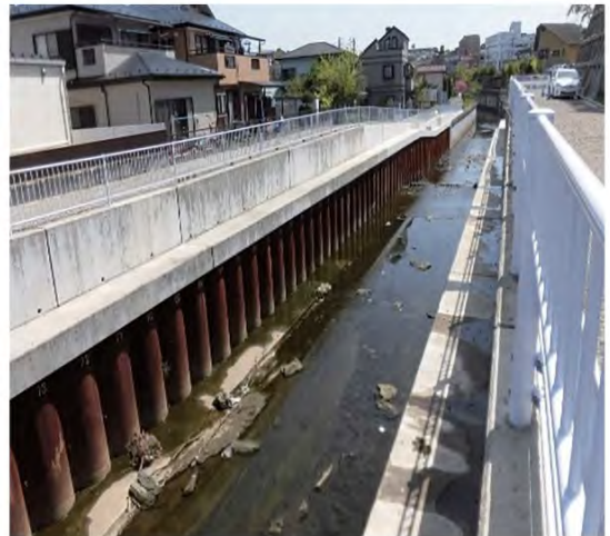
▲直壁護岸 (今井川)
