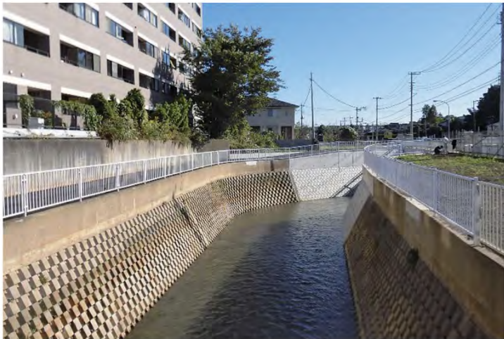
▲ブロック積護岸 (奈良川)
