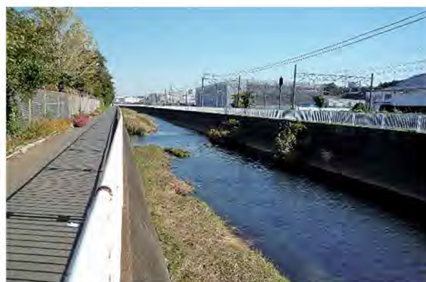
▲ 鉄道に隣接する特殊堤（平戸永谷川）
