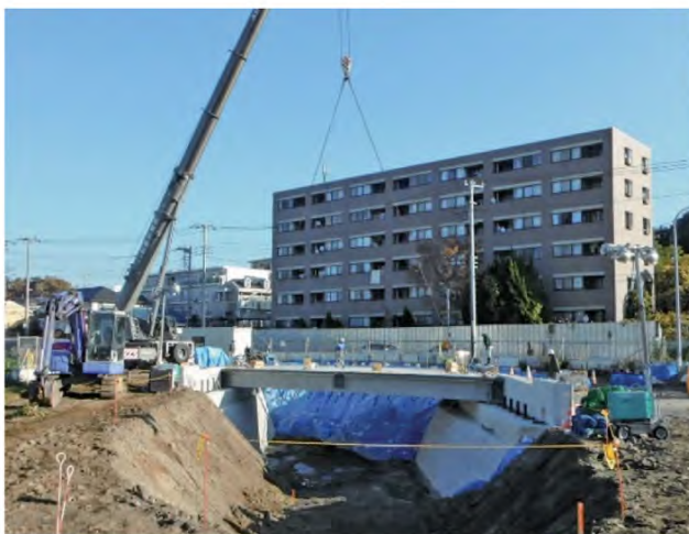
▲橋げたの架設状況 (奈良川)
