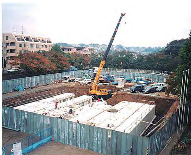
▲校庭での施設整備(北方小学校)
