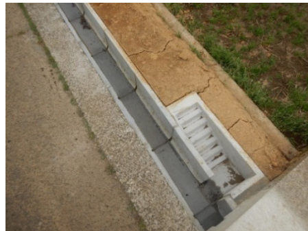
【改修した水路】（青葉区）
