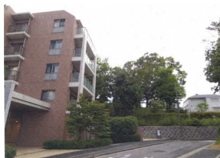
【保全契約の事例】（磯子区）
