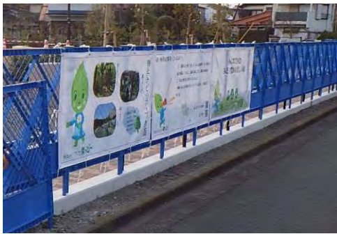
工事現場での現地表示
