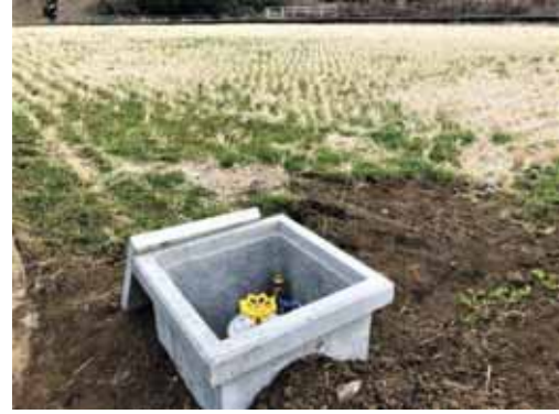
水田の用水路の修繕(泉区)
