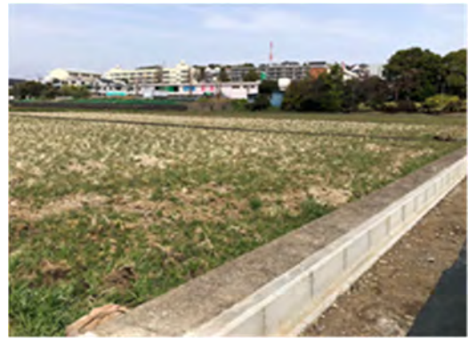
水田の用水路の更新(青葉区恩田町)
